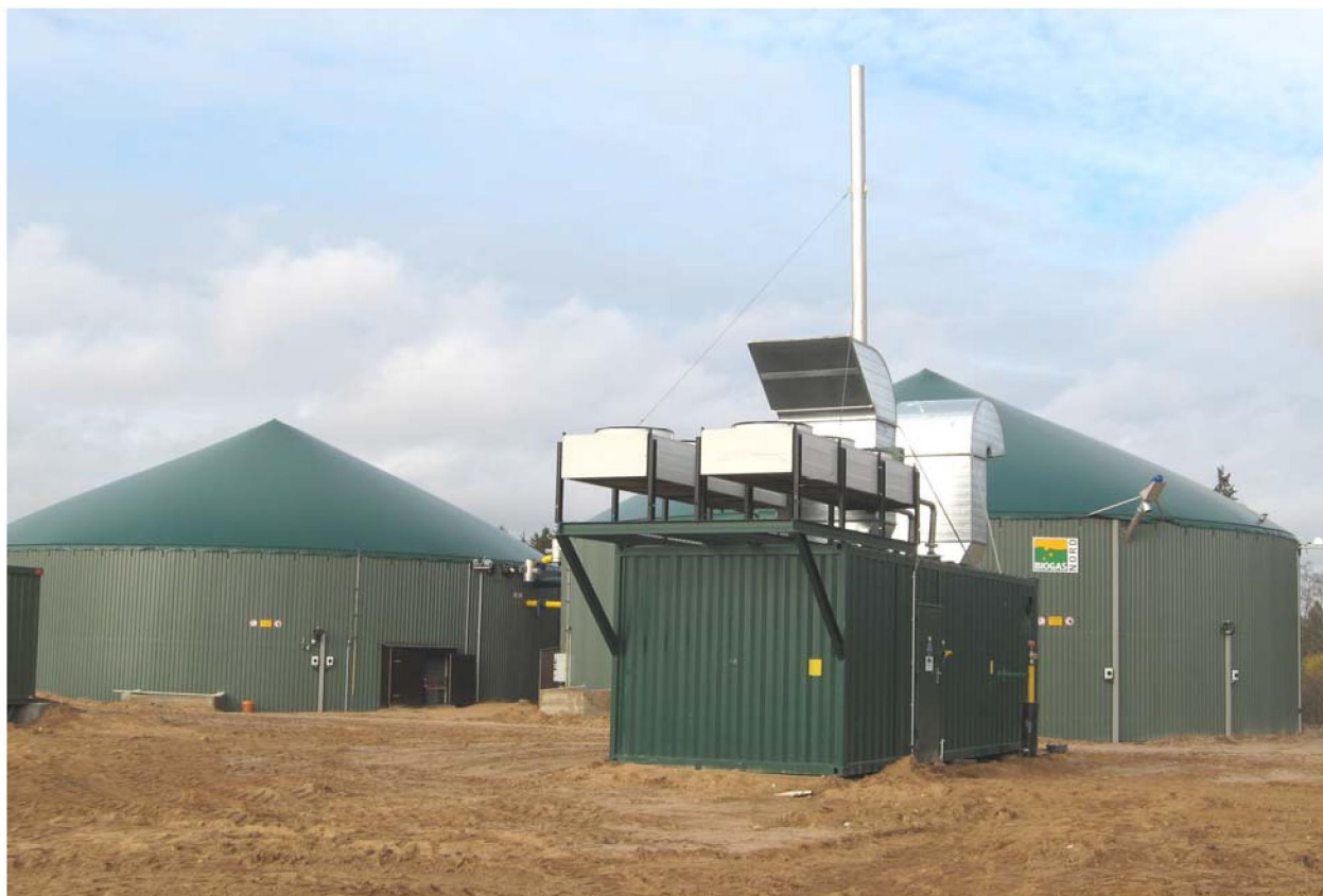
Рис. 39. Биогазовый комплекс племптицевода «Белорусский»
