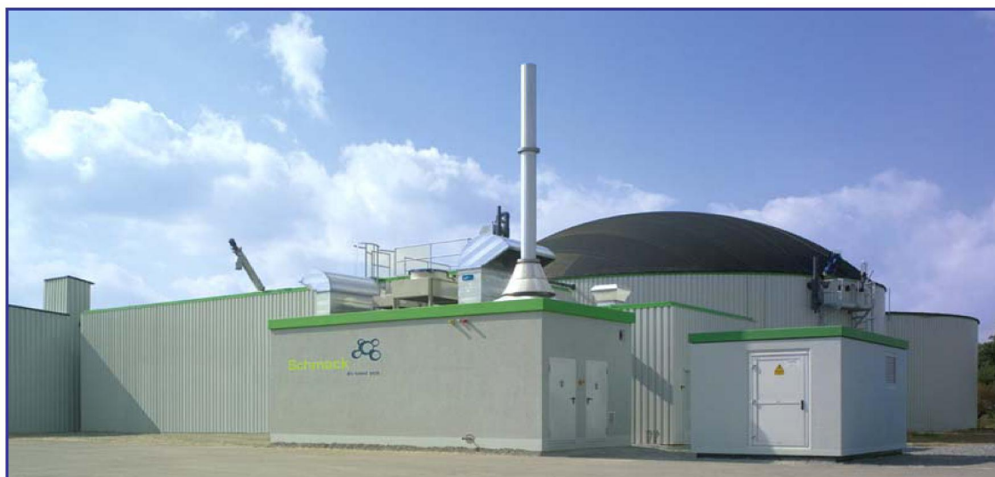
Рис. 41. Общий вид биогазового комплекса мощностью 1 МВт
